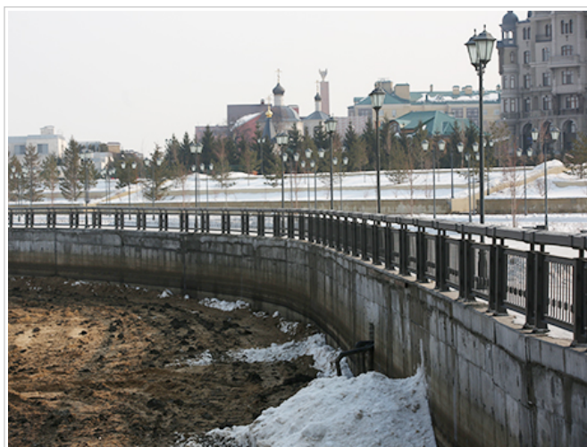
От ул. Батурина до НКЦ «Казань» благоустроен участок в 1278 метров. Сейчас компания приводит в порядок оставшийся участок — до моста «Миллениум», а это еще 1,4 тыс. м
