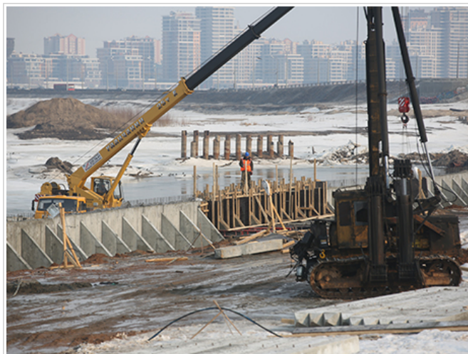
ПСО «Казань» построит три яруса подпорных стенок вдоль берега реки Казанки. Торчащие из воды сваи резервного моста будут убраны
